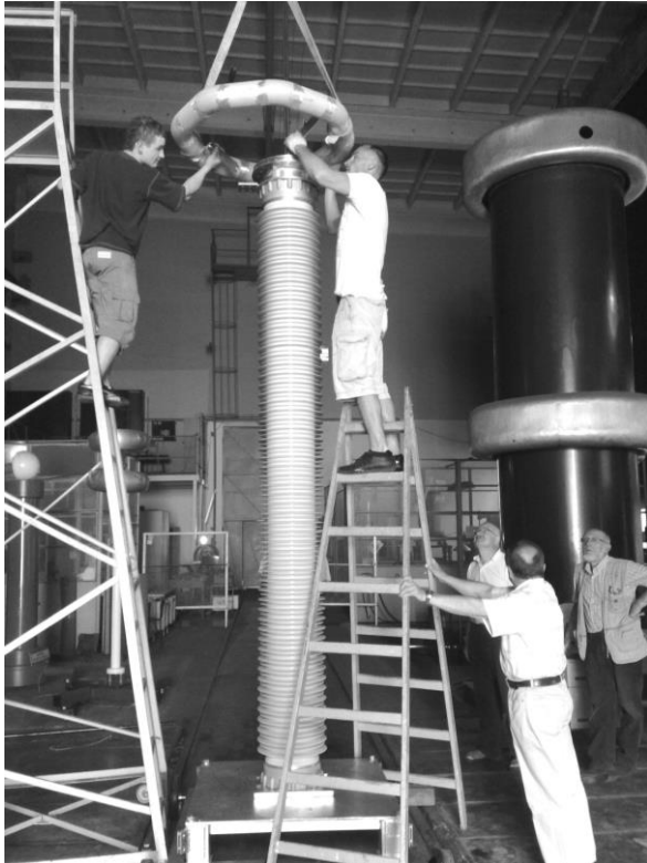
Rys. 4. Montaż dzielnika napięcia
